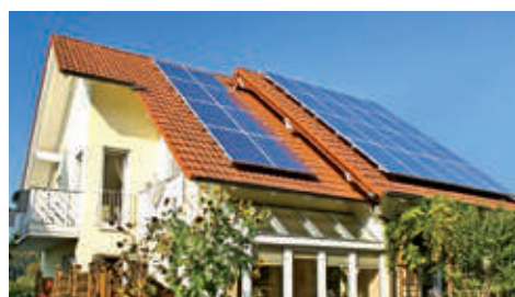
I pannelli solari trasformano il calore del sole in energia
